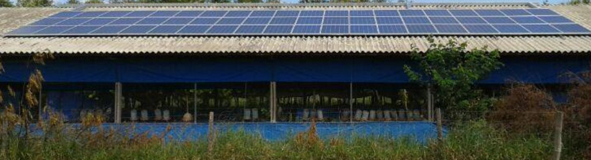
Instalação de sistema solar fotovoltaico conectado à rede, sobre cobertura de granja, localizada em Floreal - SP.
